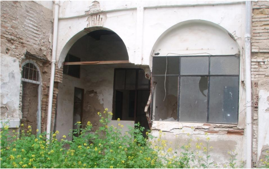
Fig. 6. Casa nº 10 (actual)
