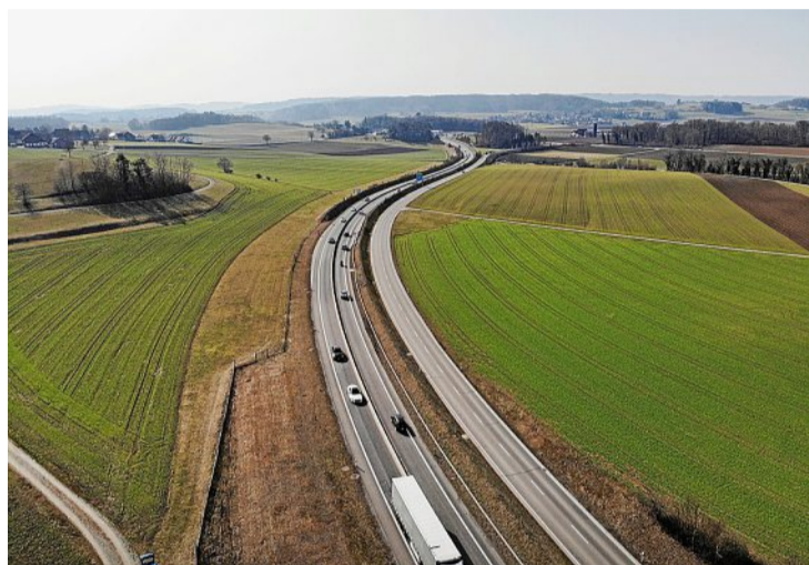
Blick auf die Autobahn A4 (links) zwischen Andelfingen und Adlikon, rechts ist die parallel dazu verlaufende Kantonsstrasse zu sehen. Foto: M. Schoder
