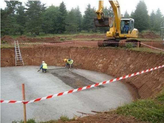
Béton de propreté : sous-couche de béton d'environ 30 m<sup>3</sup> destinée à obtenir une dalle de niveau et suffisamment stable pour accueillir le ferrailage de la fondation.
