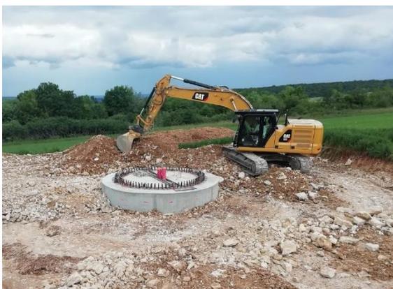
Remblaiement et compactage : après séchage, l'excavation est remblayée avec une partie des matériaux excavés (900 m<sup>3</sup>) et compactée de façon à ne laisser dépasser que la partie haute de l'insert sur lequel viendra se positionner le premier tronçon du mât de l'éolienne.
