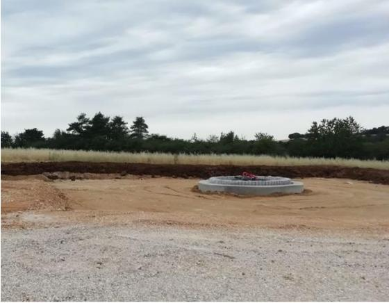
Les fondations seront enterrées sous le niveau du sol naturel. Seule l'embase du mât, d'un diamètre de 6 mètres maximum, sera visible au sol. **La semelle béton, d'un diamètre 25 m environ sur 3 m de profondeur, est enterrée et non visible.**
