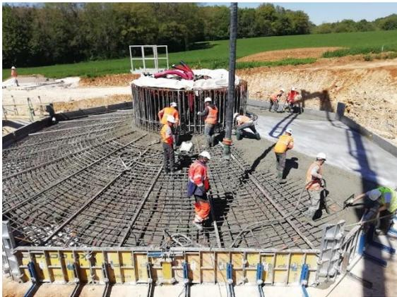
Coulage : le béton est ensuite coulé à l'intérieur du coffrage à l'aide d'une pompe à béton. 40 à 45 rotations de toupies seront nécessaires pour acheminer sur le site environ 300 m<sup>3</sup> de béton/fondation. Sur la phase finale du coulage, un produit de cure devra être mis en place pour éviter la fissuration du béton.
