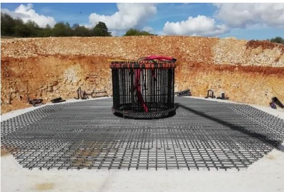
Pose du système d'ancrage : c'est le « support » de l'éolienne. Il est tout d'abord posé sur des pieds métalliques. Il est ensuite inclus dans la masse de béton.
