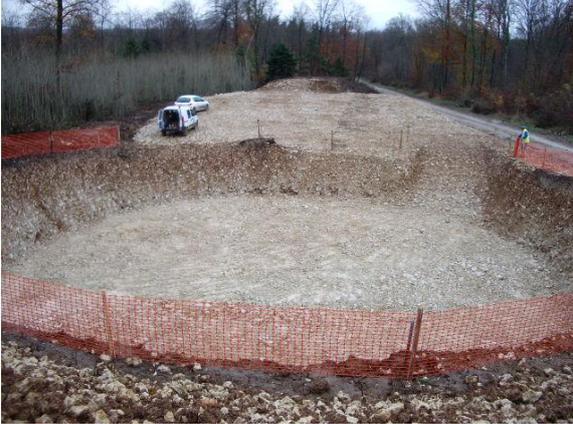
Excavation : à l'emplacement prévu pour l'éolienne, il est réalisé une excavation suffisante pour accueillir la nouvelle fondation, une fois que l'ancienne fondation aura été déconstruite. Les matériaux de déblai (environ 1200 m<sup>3</sup>) sont stockés pour réutilisation si leurs propriétés mécaniques le permettent ou bien évacués vers un centre de traitement adapté.
