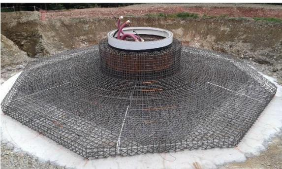
Ferrailage : avant d'effectuer le coulage du béton, il faut réaliser l'armature métallique qu'il va renfermer (environ 40 tonnes). Cette armature rendra le futur massif de béton extrêmement résistant.
