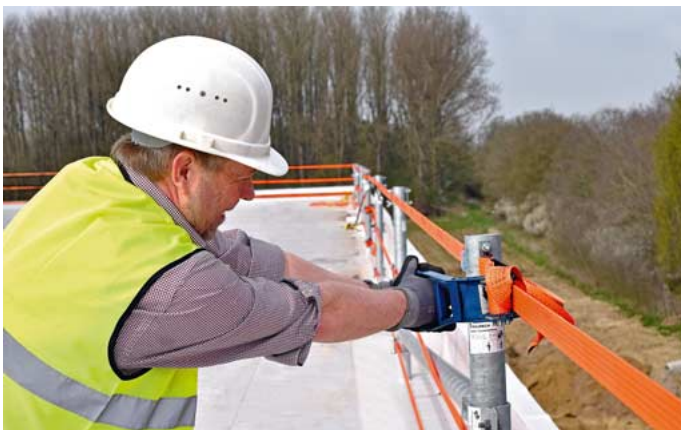
»Roof Xafe« schützt die Beschäftigten auf Flachdächern mit bis zu 15°. Die Montage des Systems ist einfach: Die Hülsen für die Pfosten werden auf die vorhandenen Stahlträger oder Betonteile befestigt.
