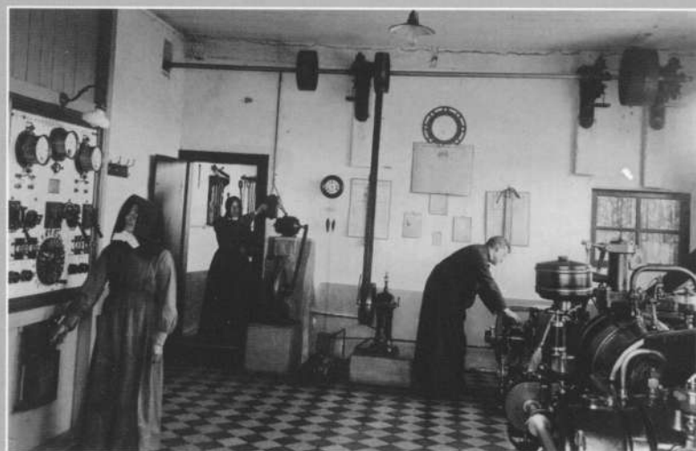
Anlagenraum zur Erzeugung von elektrischem Strom (Foto: Archiv des Mutterhauses der Kongregation der Schwestern vom hl. Paulus, Steffen Roth)
