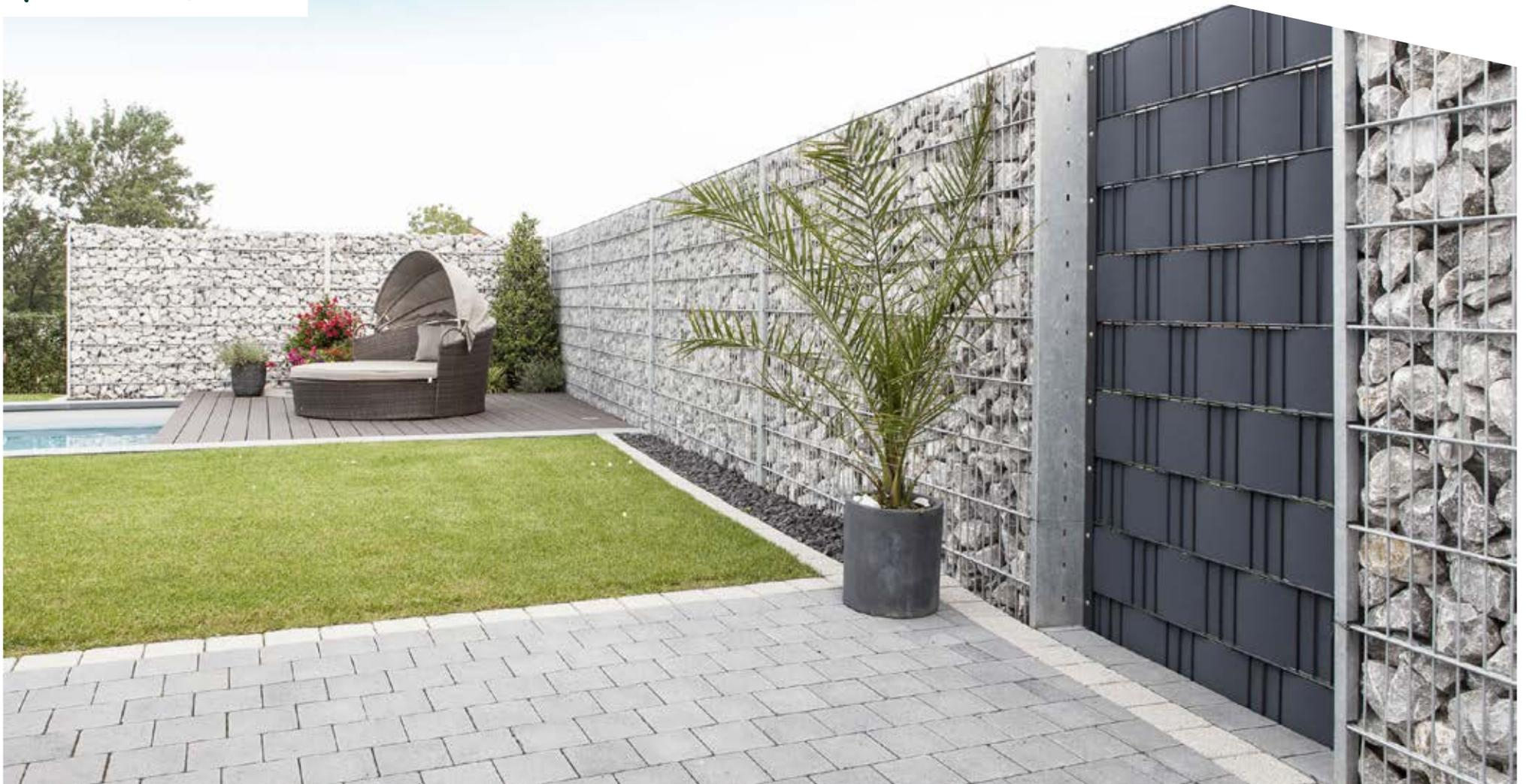
Der Gabionenzaun besteht aus verzinkten U-Profilblechen, die als Pfosten dienen. Durch das einfache Montieren der Doppelstabmatten entsteht in kurzer Zeit der Gabionenzaun und wirkt durch das Design sehr edel. Durch die vielen verschiedenen Einsatzmöglichkeiten sind Ihren Wünschen/Vorstellungen keine Grenzen gesetzt.
