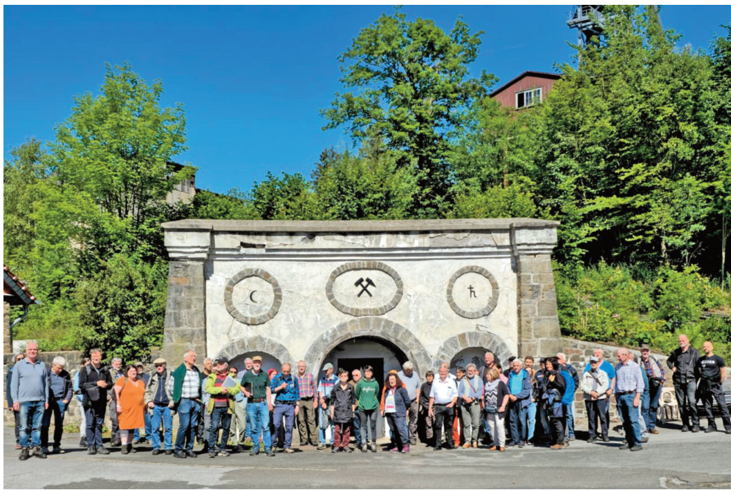
An der Führung durch die Tagesanlagen des ehemaligen Erzbergwerks Grund (Grube Hilfe Gottes) hatten rund 60 Teilnehmer großes Interesse. FOTO: privat
