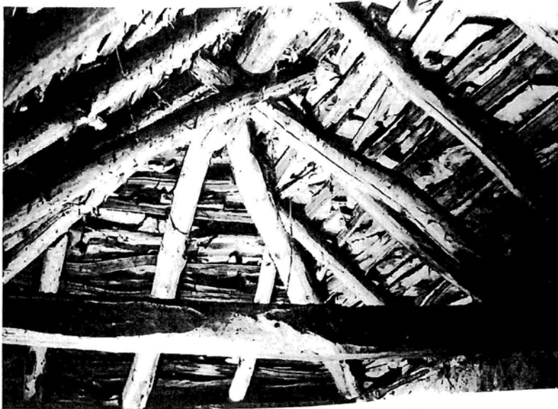
Travatura di un tetto completamente in tronchi di castagno.
