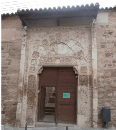
Fig. 15 Entrada del convento de Santa Isabel
