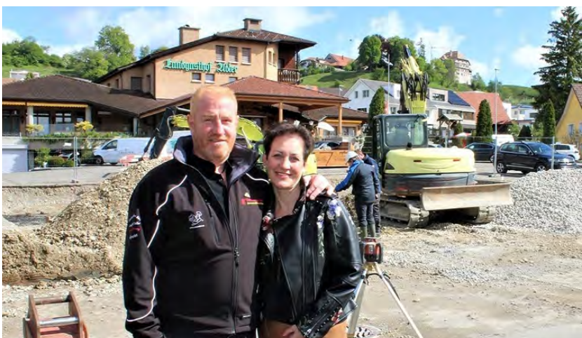
Die ersten Baumaschinen sind im Mai 2021 aufgefahren. Marcel und Rosemarie Mettler vor der Baustelle, mit dem Landgasthof Adler im Hintergrund. Bild: Ernst Inauen
