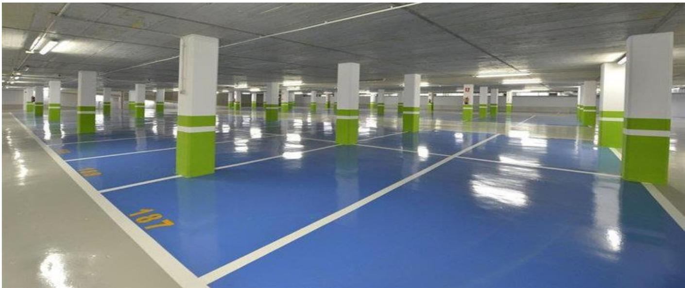
Recubrimiento epoxi de bajo espesor con textura de acabado lisa o antideslizante para sollicitaciones mecánicas bajas-medias.
