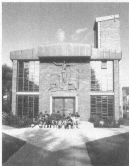
Protestantische Kirche nach Abschluß der Renovierungsarbeiten mit Konfirmandengruppe.
