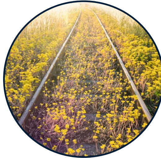
Sanierung und Reaktivierung von Eisenbahnstrecken
