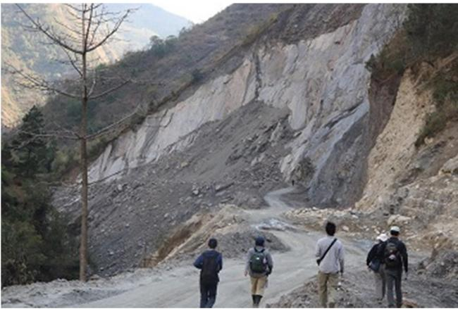
図 12-1 道を塞ぐ斜面崩壊
