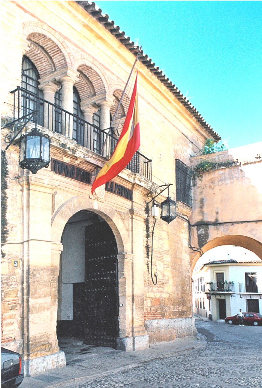
Vista actual del edificio de las Caballerizas Reales de Córdoba donde se gestó esta empresa.
