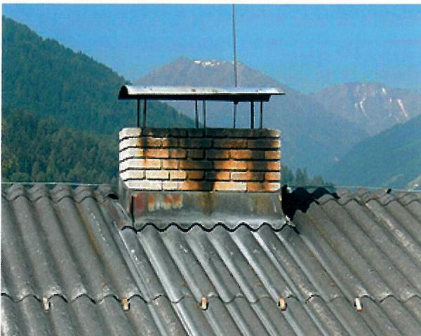
Die negativen Nebenwirkungen des herkömmlichen Kamindaches oder anderen starren Kaminaufsätzen sind bekannt, da sich beim Heizen darunter eine **Wärmeblase** bildet, **welche auf die Mündung drückt und so den Zug im Kamin massiv verschlechtert**. Die Rauchgase kühlen zu früh ab und es beginnt der Kamin innen zu versotten. Auch außen kommt es oft zu Ablagerungen, welche sehr schnell zu **unschönen und schädlichen Auswirkungen auf dem Kamin und Schäden auf dem Hausdach** führen.
