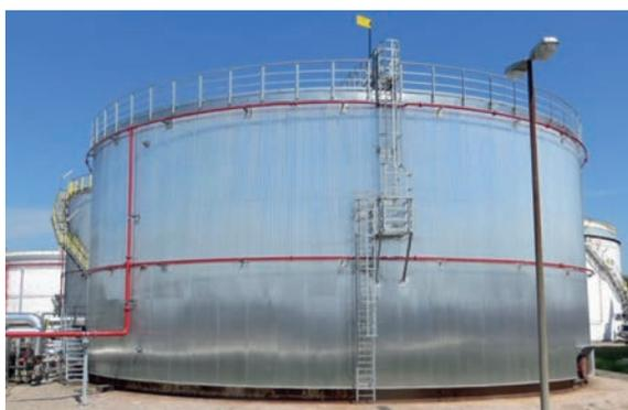
Zur Reduzierung der Wärmeenergie-Verluste hat TotalEnergies die Tankisolationen erneuert. © TotalEnergies
