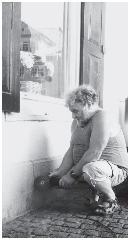
Renovationen: Steinmetzarbeiten im Erdgeschoss
