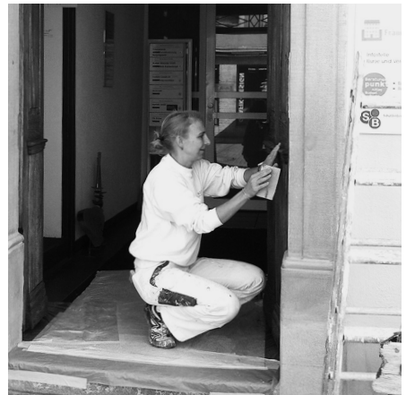
Renovationen: Malarbeiten «von Kopf bis Fuss»
