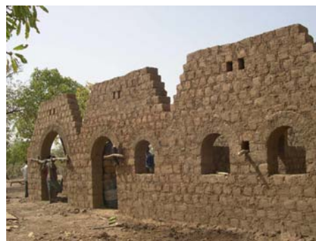
Murs pignons de façade
