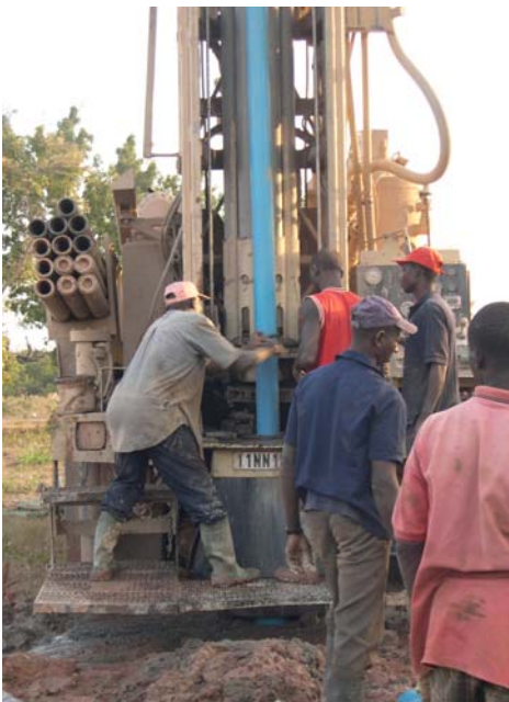
Machine de forage en action
