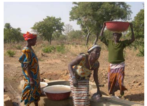
L'eau pour la maçonnerie
