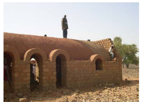
Voûtes nubiennes pour couvrir
