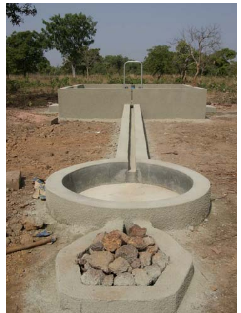
Maçonnerie autour de la pompe
