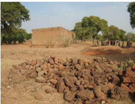
Fondations en pierre
