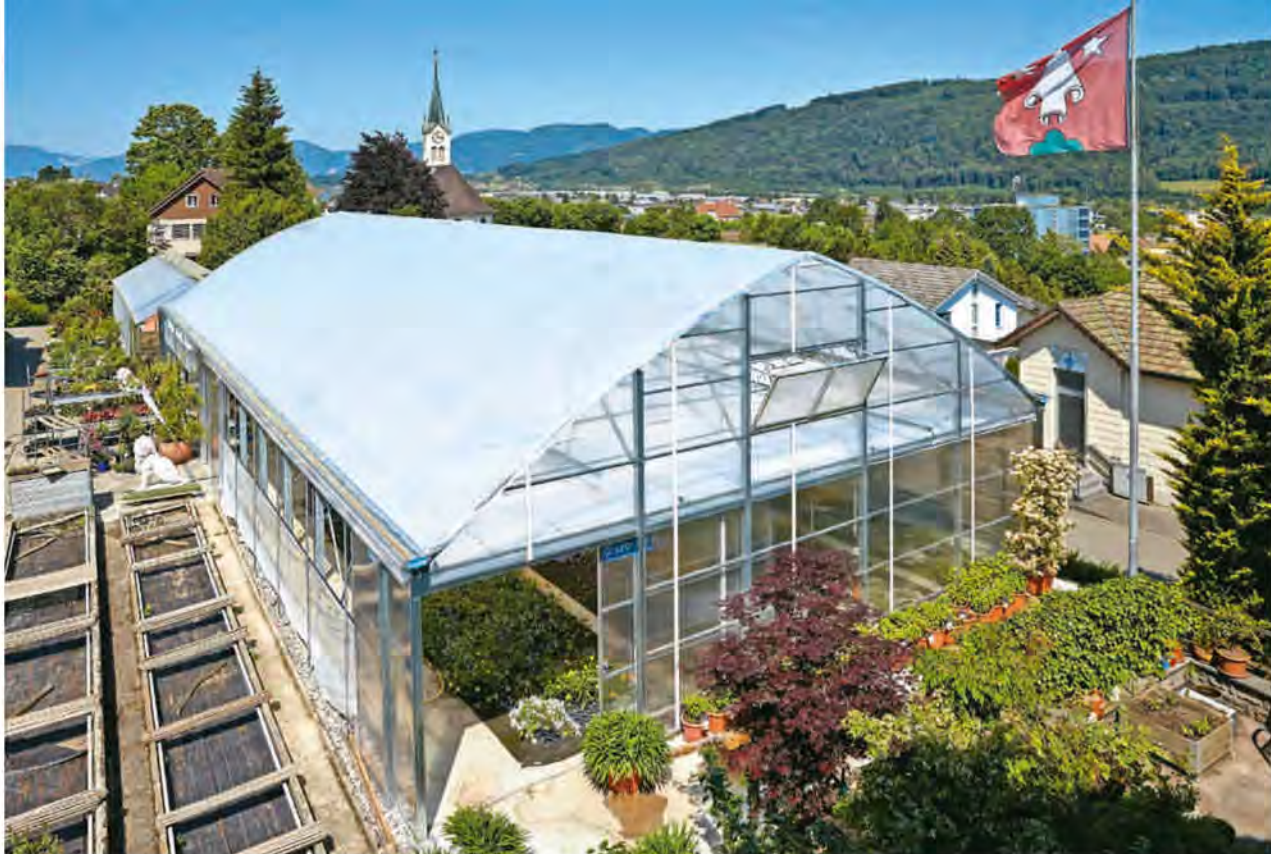
Das «Triibhuus» wurde als Eventhalle konzipiert und weist eine Fläche von 300 Quadratmetern auf. Im Hintergrund die Kirche, wo sich die Parkplätze befinden.
