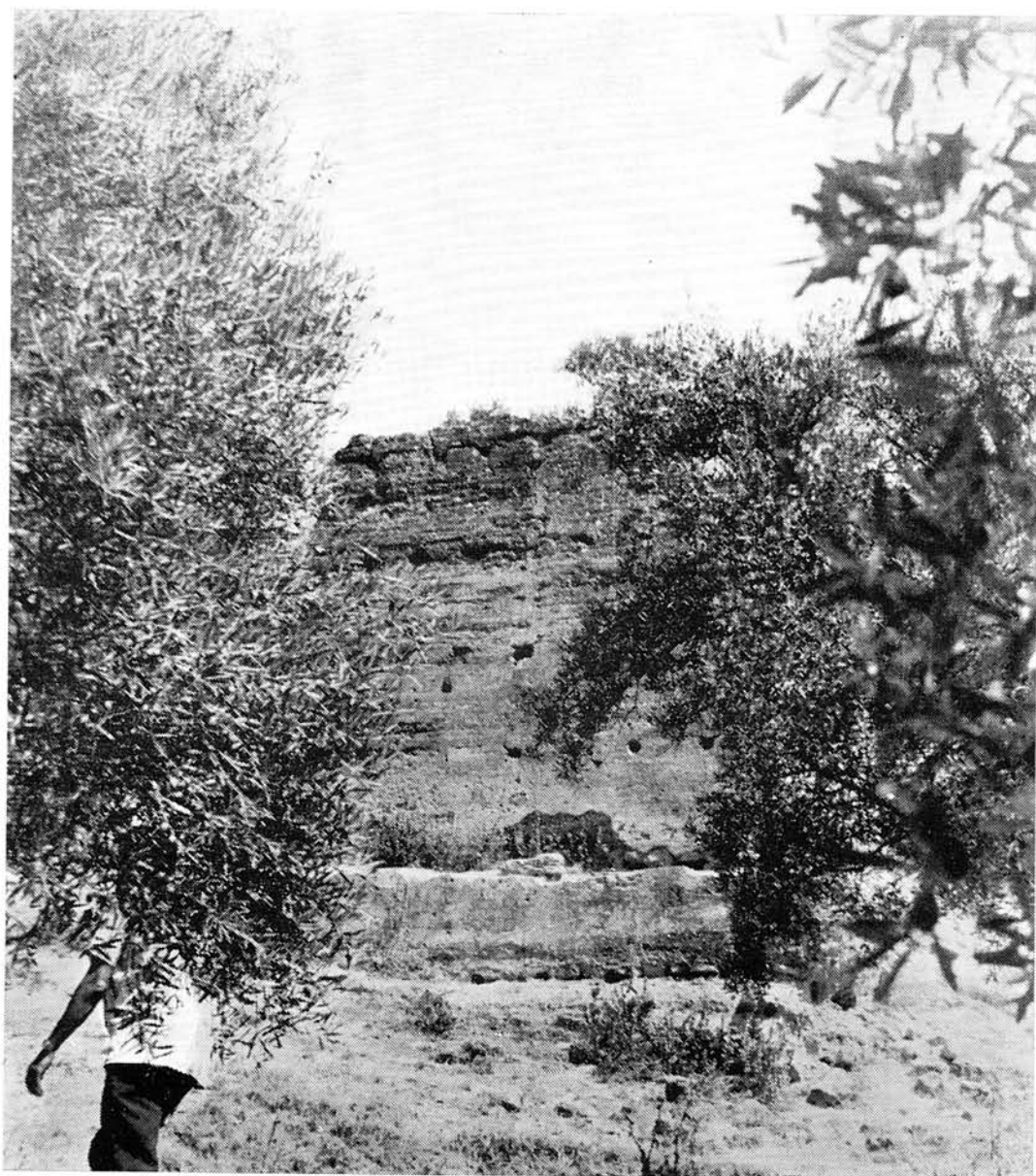
VISTA DEL TORREON SUROESTE DE LA FORTALEZA. PUEDEN OBSERVARSE LOS AGUJEROS ADONDE SE COLOCABAN LOS TRAVESAÑOS PARA HACER EL TAPIAL DE ARGAMASA. (FOTO DEL AUTOR)
