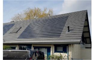
Wie beim G10 PV Modul, wird das Planum PV Modul direkt auf die Dachlattung gelegt.
