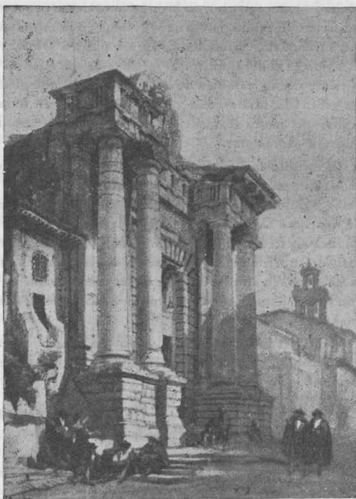
Puerta del Puente.-Grabado antiguo
