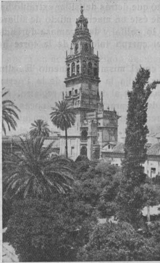
Vista panorámica actual de la torre de la Mezquita-Catedral
