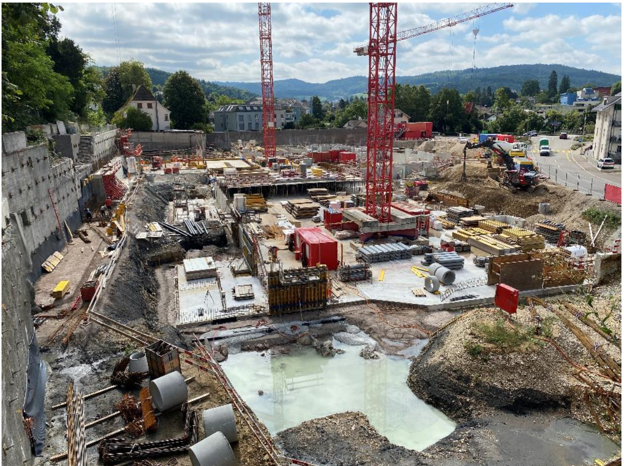
20. August 2024: Hangabsicherung. Erste Decken werden betoniert
