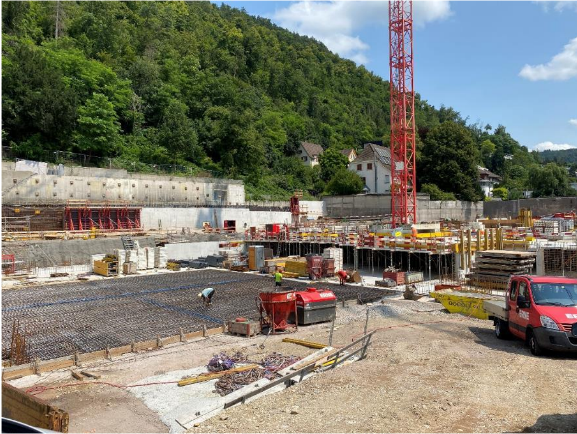
24.07.2024: Die Eisenleger sind an der Arbeit. Im Hintergrund wird die Bergseite verstärkt.
