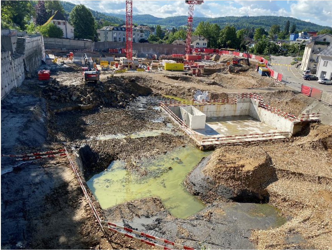
24. Mai 2024: Gesamtansicht der Überbauung
