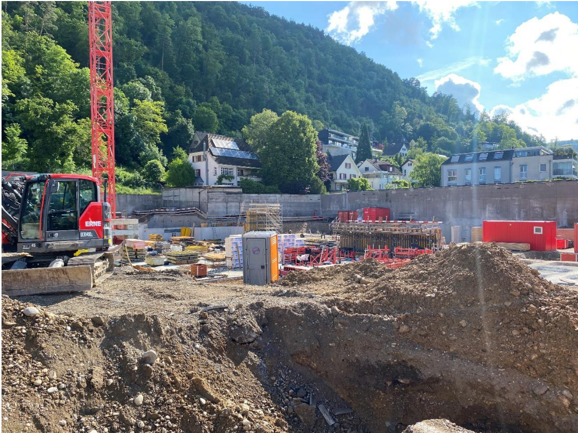
24. Mai 2024: Das Kellergeschoss ist am Entstehen
