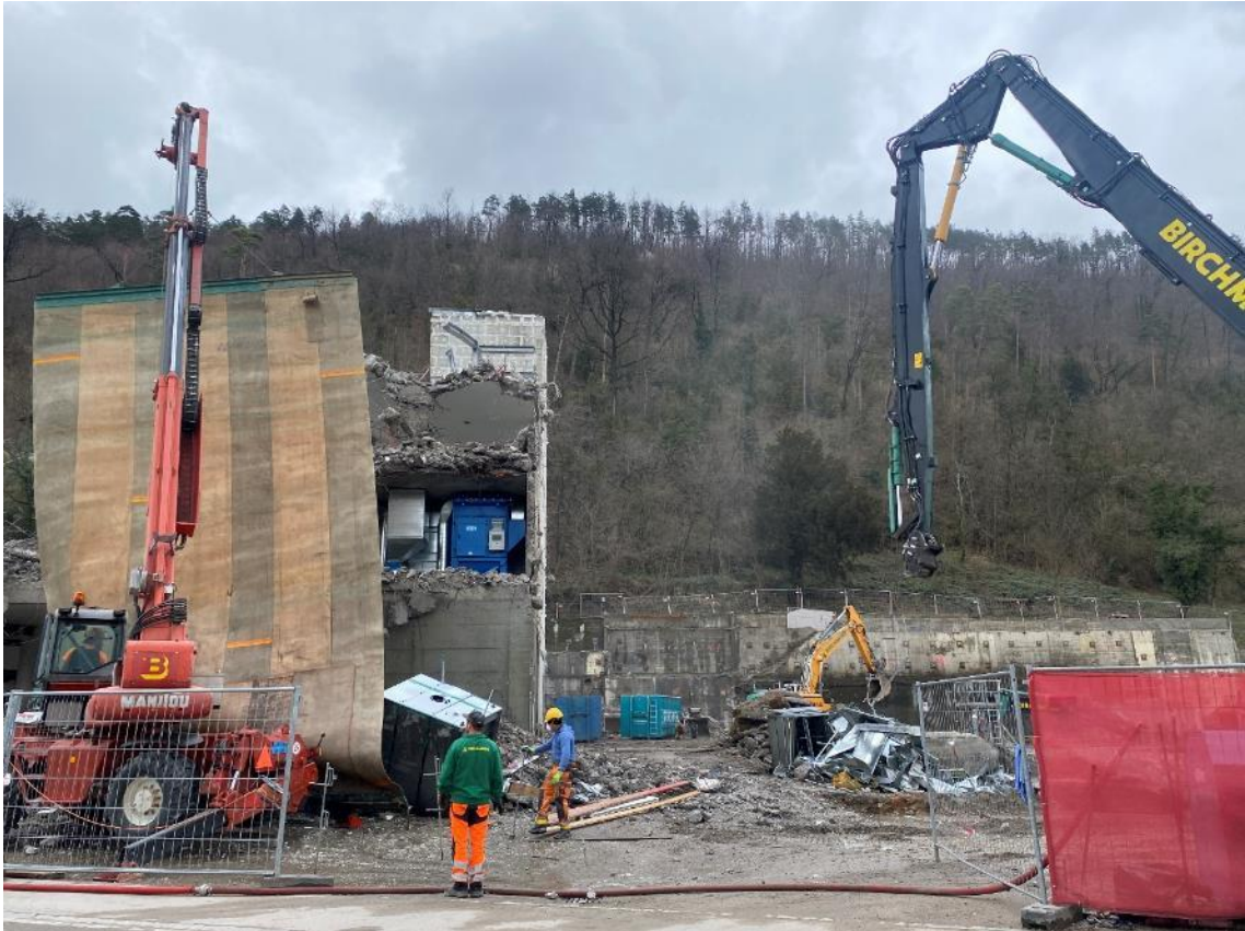
18. März: Mit dem Staubschutz wir Teil um Teil abgeklemmt
