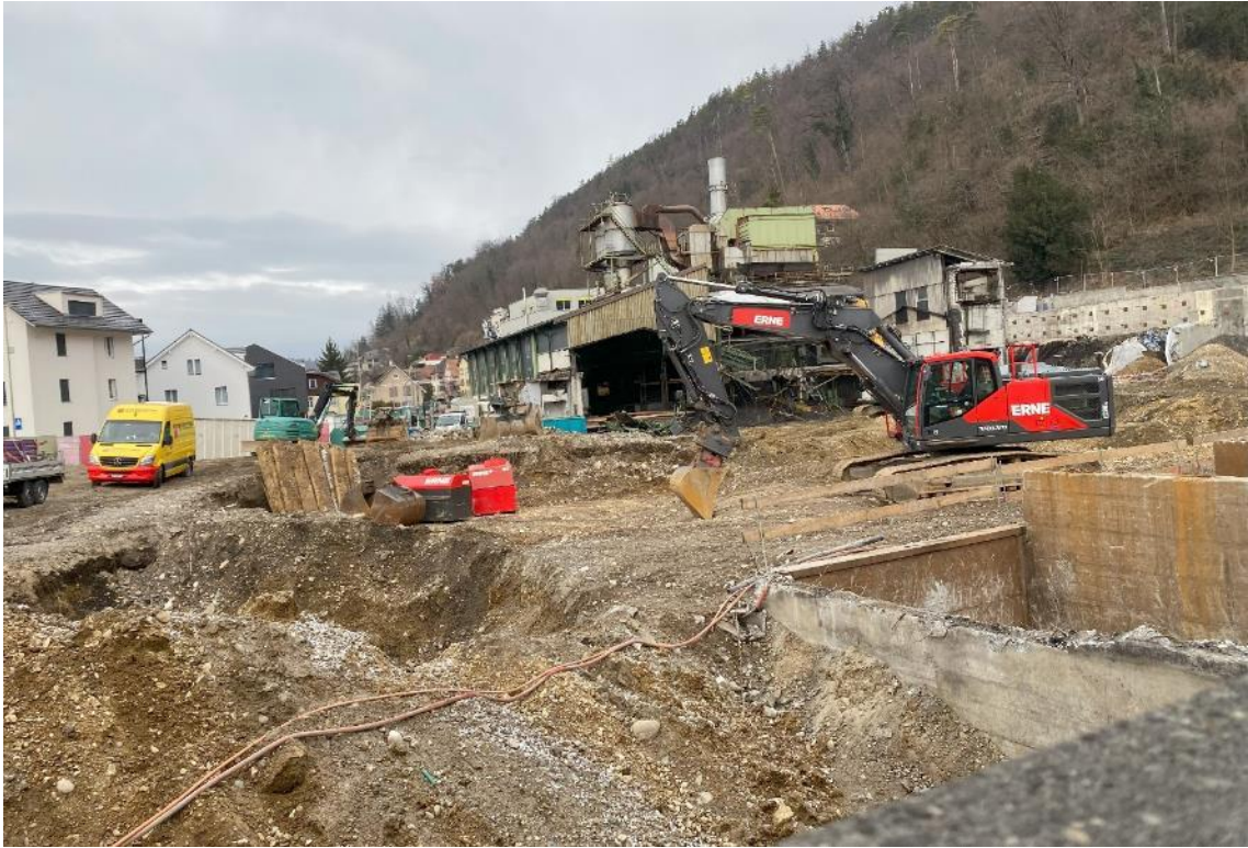
30. Januar 2024. Stück für Stück werden die Gebäudeteile abgerissen und entsorgt. Mehrere Bagger heben bereits tiefe Löcher aus.
