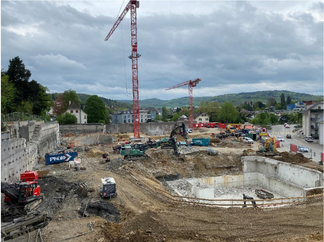
Anfang April 2024: Der grosse Kran und bald der kleinere Kran stehen. Das Verwaltungsgebäude ist freigelegt bis zum 2. Untergeschoss.
