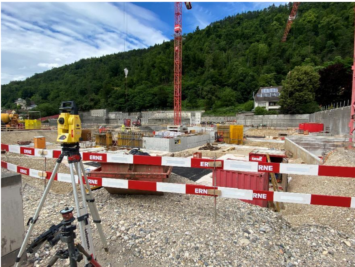
12.06.2024: Es wird fleissig betoniert
