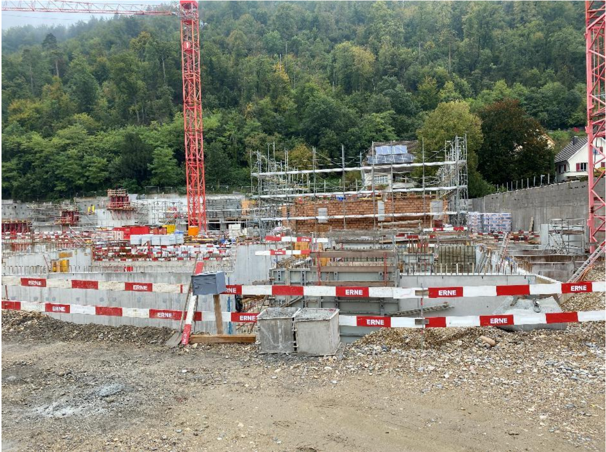
5 Oktober 2024: Das Mauerwerk beginnt zu wachsen
