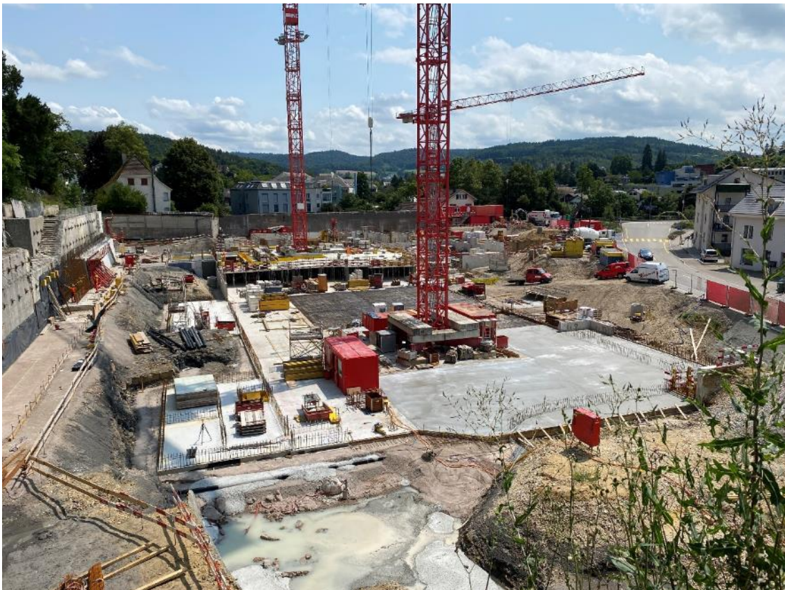
24.Juli 2024: Gesamtansicht: eisen legen .... betonieren ... Eisen legen ...
