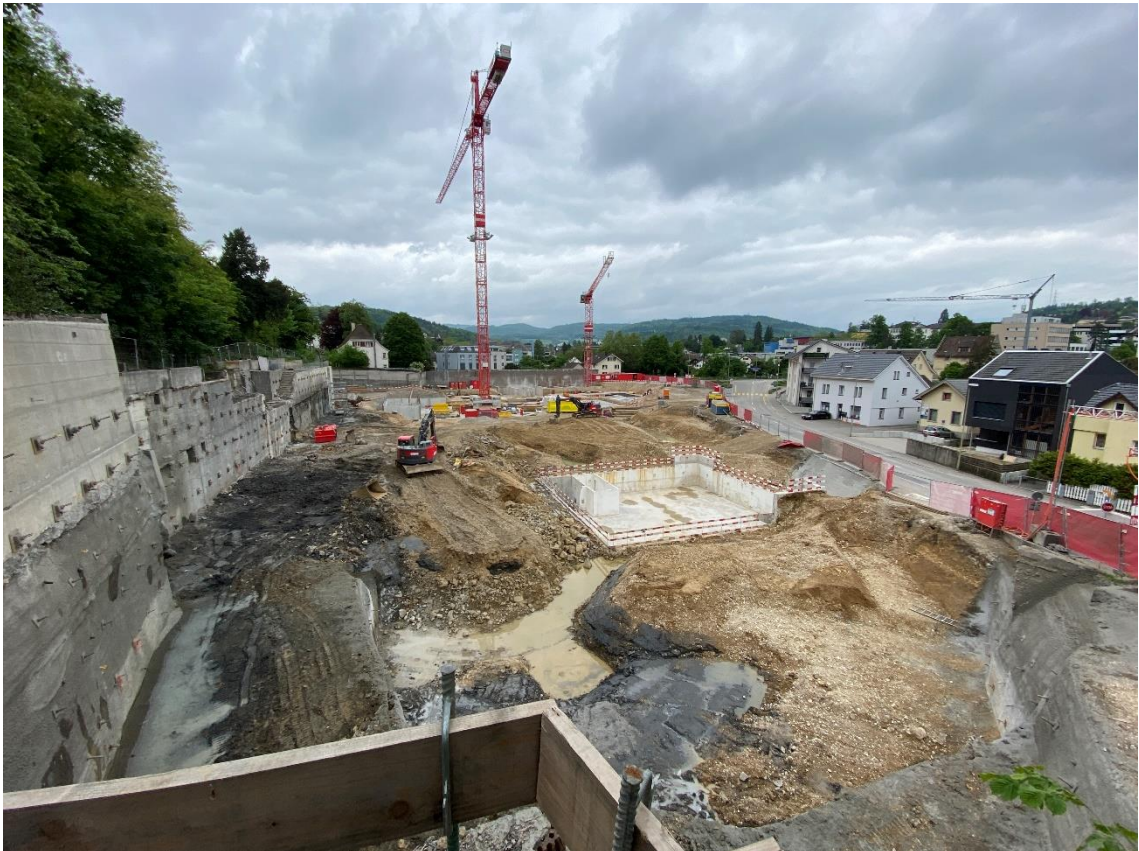
Ende April 2024: Im Hintergrund wird bereits am Keller des 1. Gebäudes gearbeitet. Die Hangsicherung ist gewaltig.
