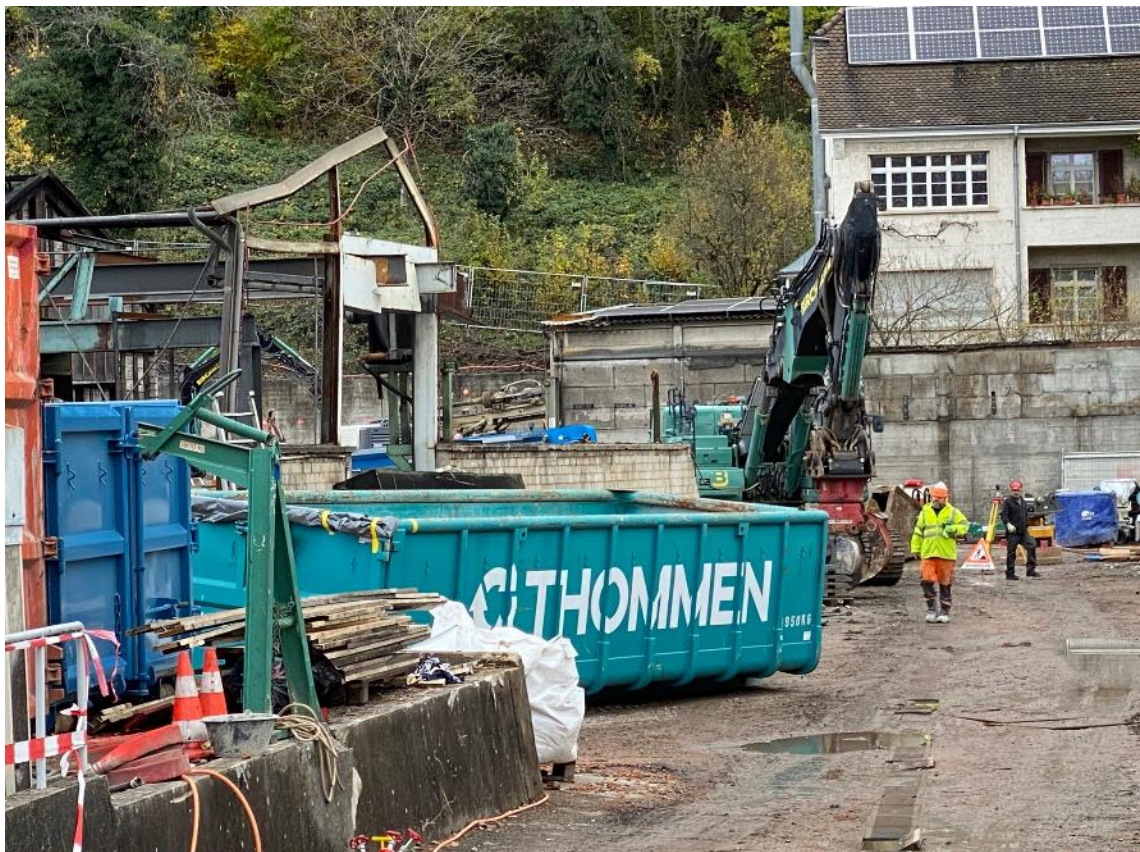
20. November 2023: Die Metallkonstruktionen der Werkhallen werden entsorgt.
