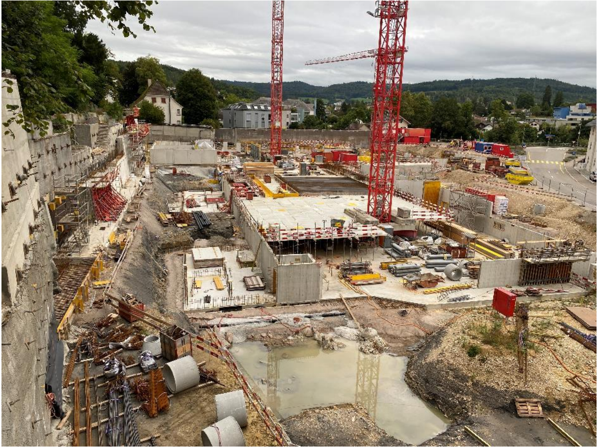
8. September 2024: Nach den Eisenlegern folgt der Beton
