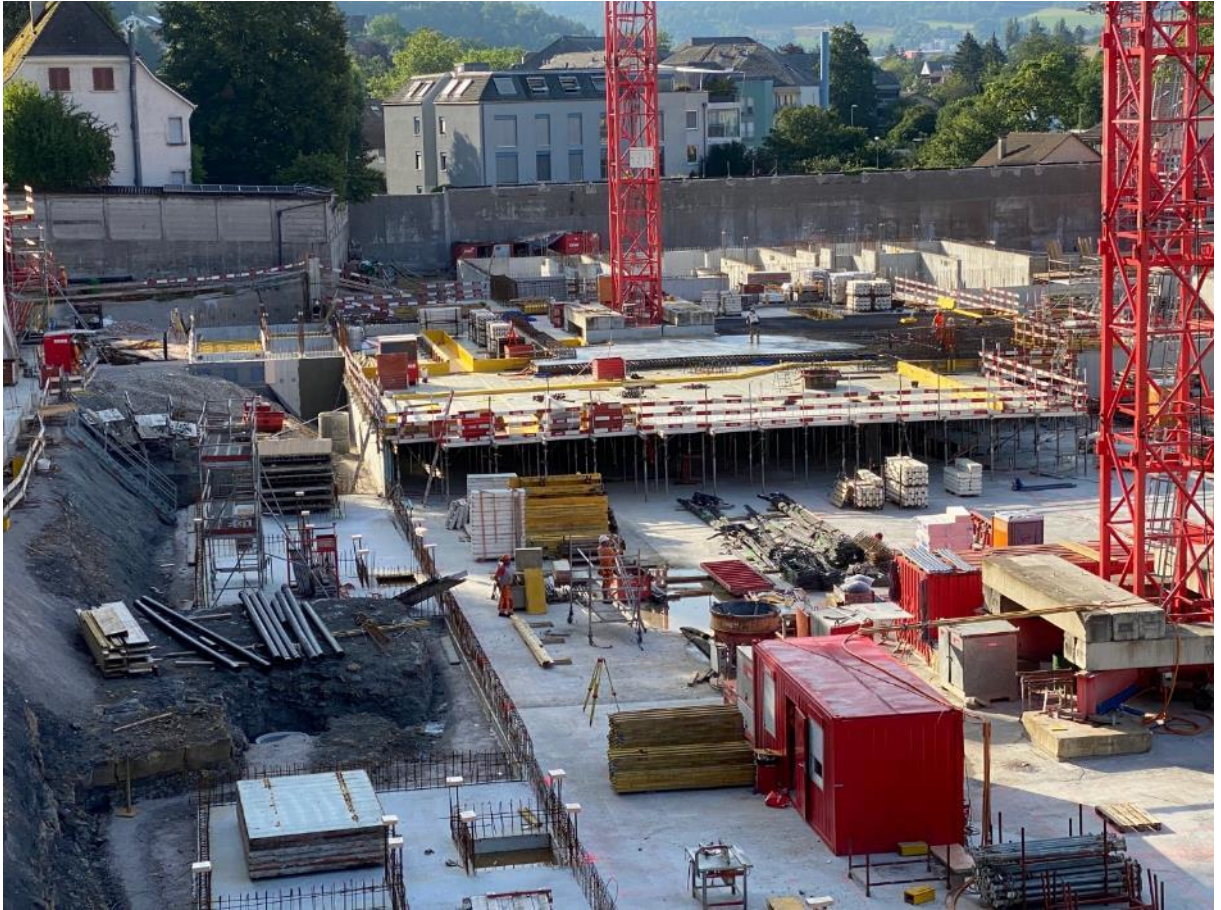
31. Juli 2024: Ein neues Geschoss entsteht
