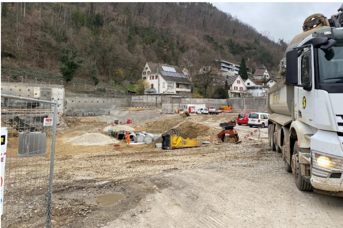
4. März: Im Aushub wird vermessen, Rohre für das Abwasser?
