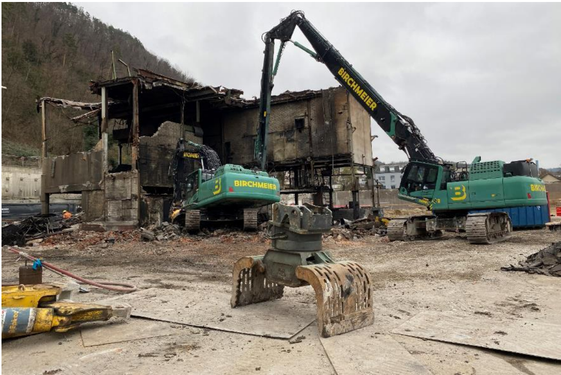
4. März: Bagger links magnetet die Stahlteile, Bagger rechts reißt sie frei.
