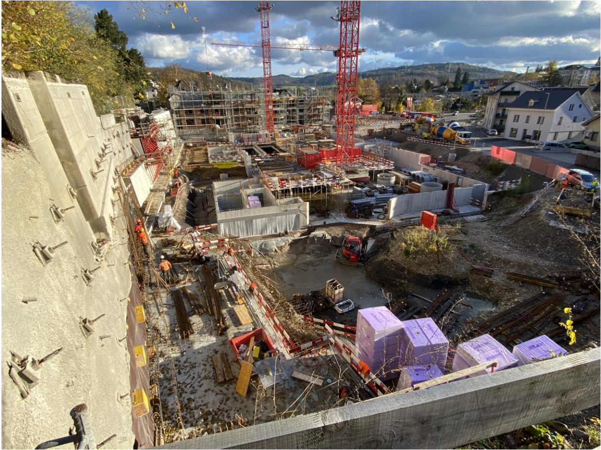
30. November: Stockwerk um Stockwerk, Hangsicherung um Hangsicherung
