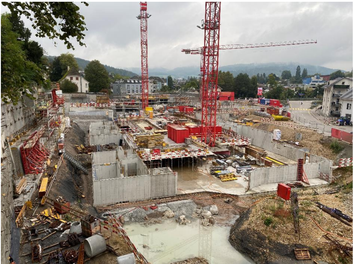
5. Oktober 2024: auch die Stützmauer bergseits kommt voran
