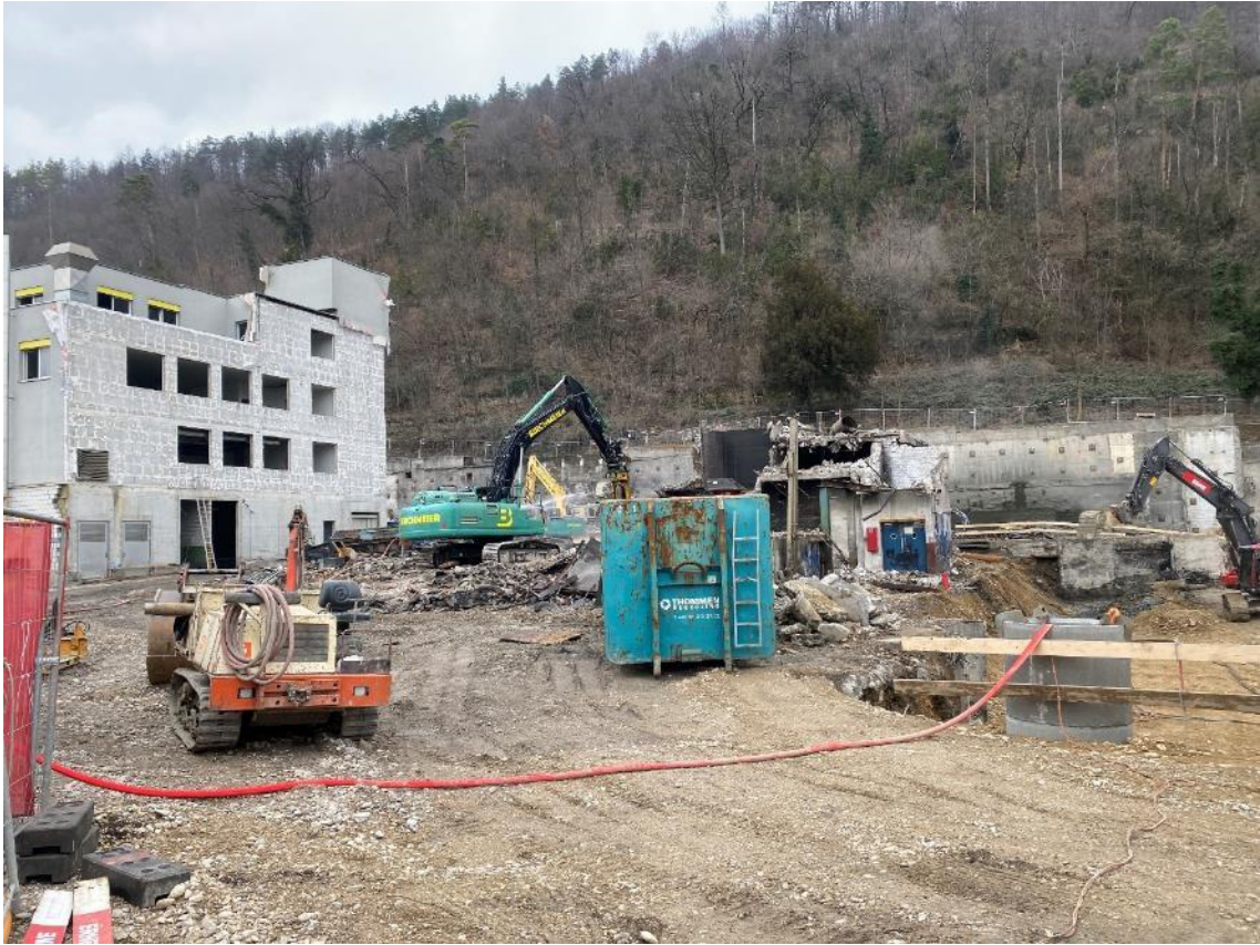
7. März: Mit schwerem Gerät die Metallteile zerlegt und abtransportiert
