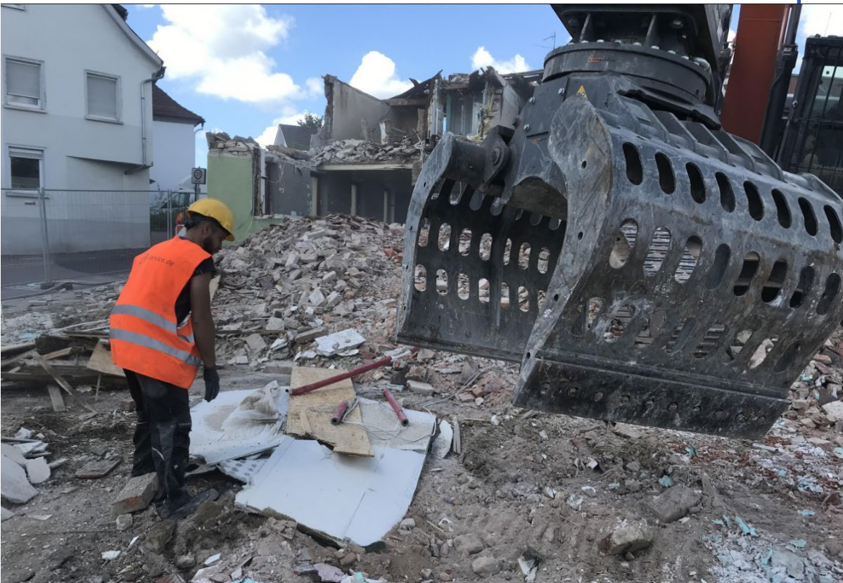
Bauschutt am Abbruchort. Foto Grossarth
