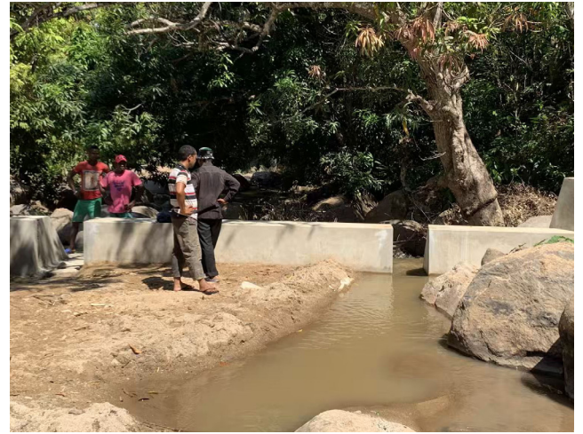
4) Barrage d'un ruisseau
