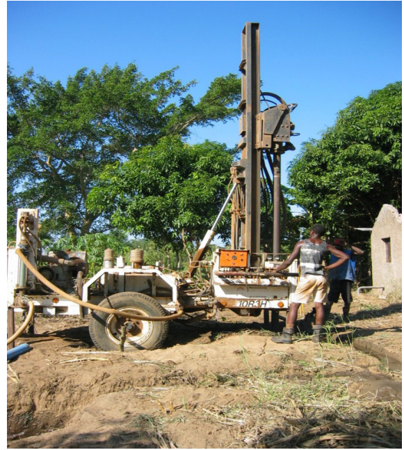
2) Forage pour les eaux phréatiques
