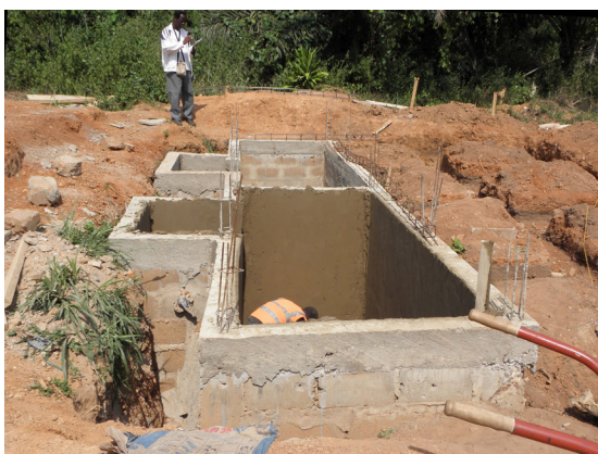
Le bâtiment avec 6 toilettes sera construit au-dessus.
