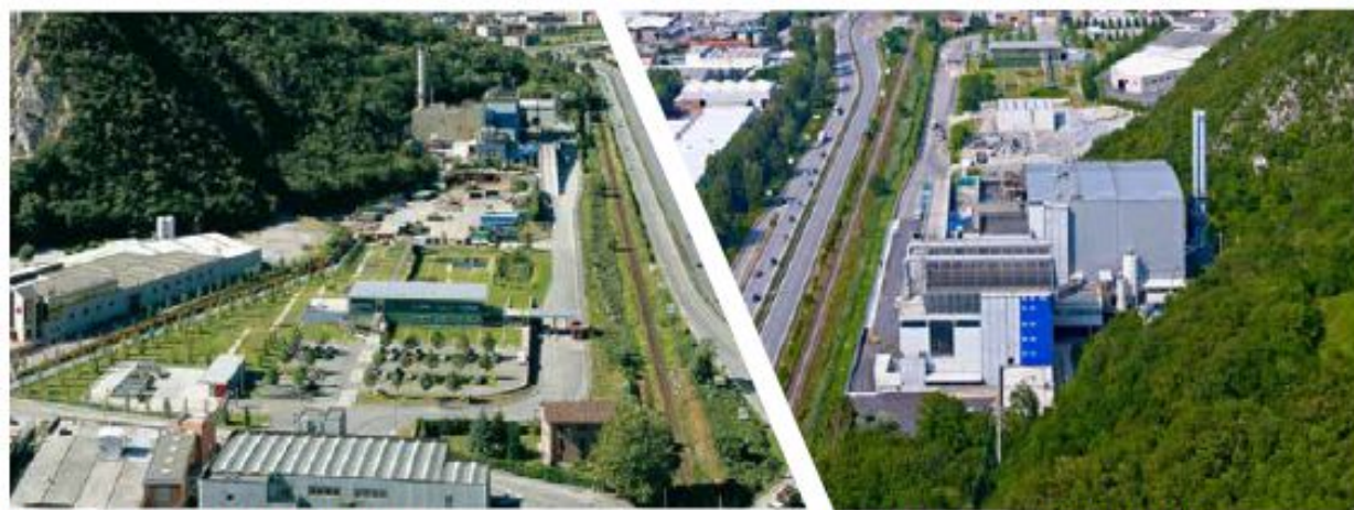
Vista in direzione Lecco - Milano
