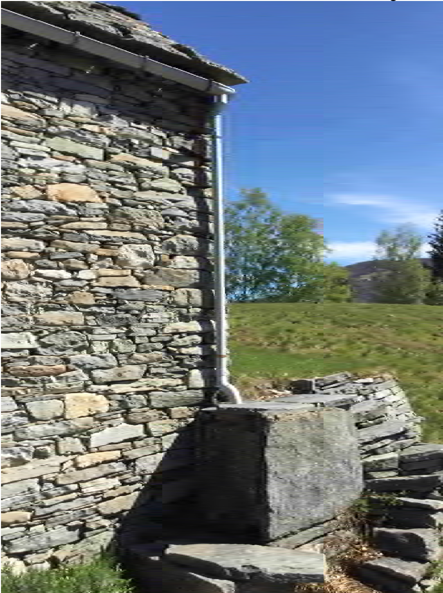
Im Weiler wird das Dachwasser in Zisternen aus Granit gefasst.
