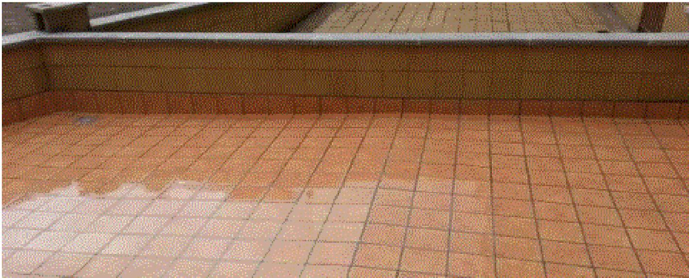
Impermeabilización de cubierta plana transitable y antideslizante transparente apta para su uso de tráfico peatonal.
