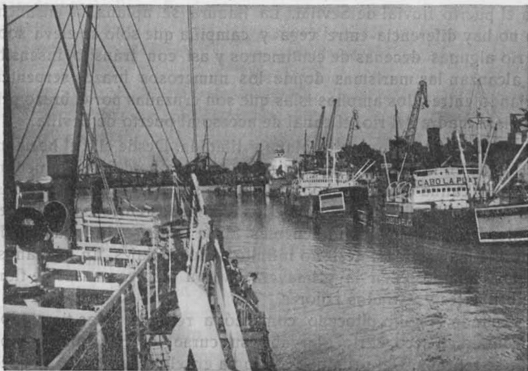
El Guadalquivir en Sevilla. Canal de Alfonso XIII, zona portuaria principal, al comienzo del tramo de desembocadura.
