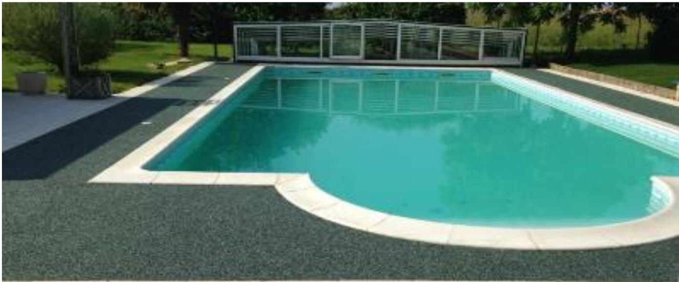
Sistema de poliurea en frío confortable antideslizante, con acabado en poliuretano alifático mate de bajas emisiones y con propiedades bacteriostáticas.
