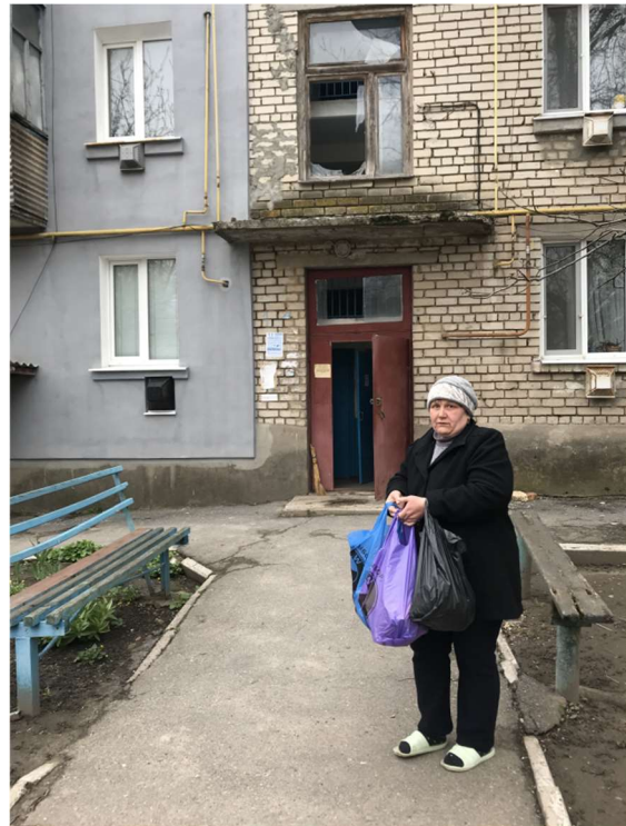
Wie auf dem Foto ganz oben sind Häuser teilweise zerstört oder beschädigt.
