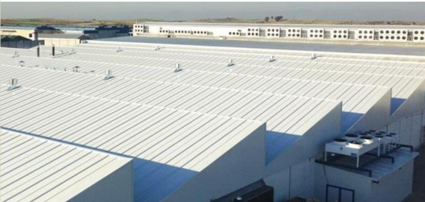
Impermeabilización de cubierta transitable mediante la aplicación de membrana líquida de aplicación in-situ.
