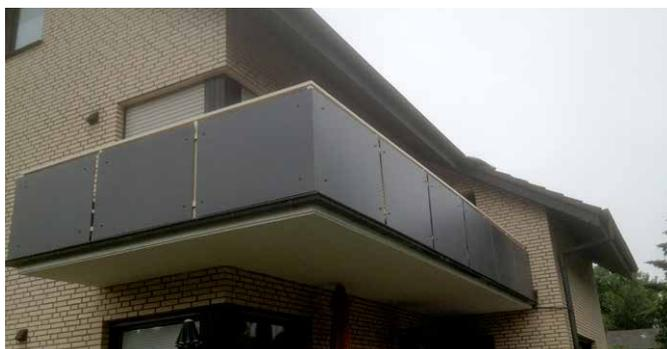
Fotos zeigen Fassaden-Schichtstoffplatten!
