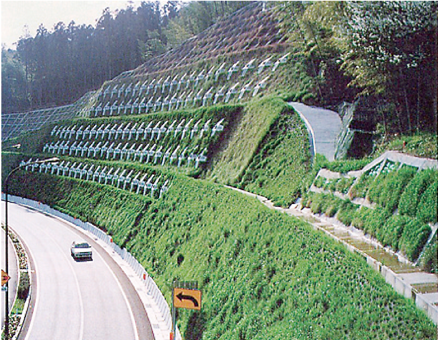
切土された道路法面の緑化事例
