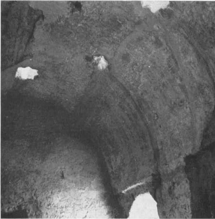
Bóveda de la habitación de entrada a los baños, con lucernas en forma de estrella de ocho puntas.
