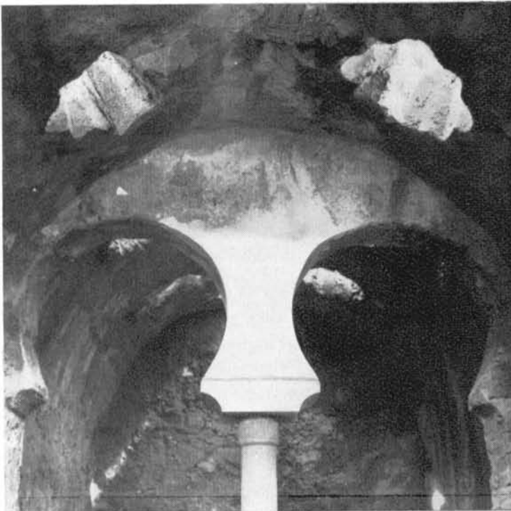
Una de las dependencias destinadas al baño de vapor o "al bayt al-voasla ni" de los baños del Alcázar Califal.
