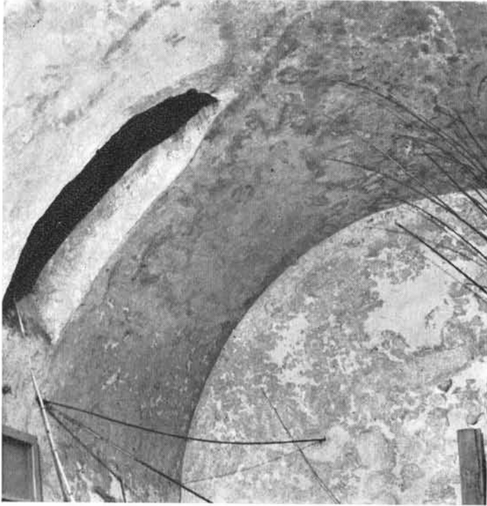
Dependencia destinada al baño con vapor de agua o “al-bayt-al voasla ni” del baño árabe de la calle del Duque (Rey Heredia).
