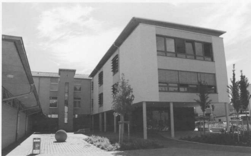
Neubau und Aufzug auf der Nordseite
