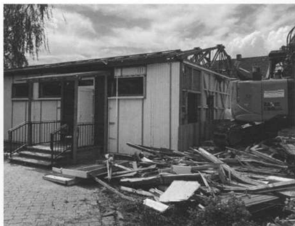
Abbruch des Pavillons im Juli 2021
