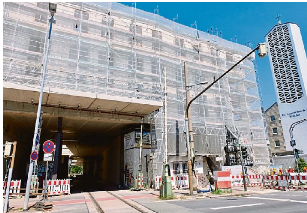
Ein ungewöhnliches Projekt: Der Neubau auf dem Braunsfelder Marktplatz direkt über der Gütertrasse
