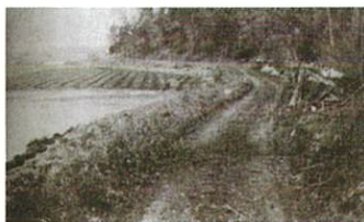
▲図-4 大館地方の新国道
