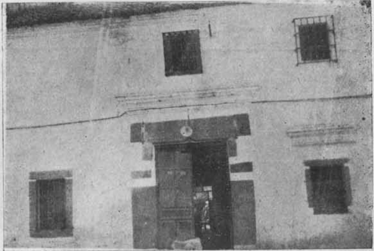
Fig. 10, a) Estructura de la casa típica en el Valle de los Pedroches, y Sierra Morena en general (granito, pizarras). Villanueva de Córdoba.
