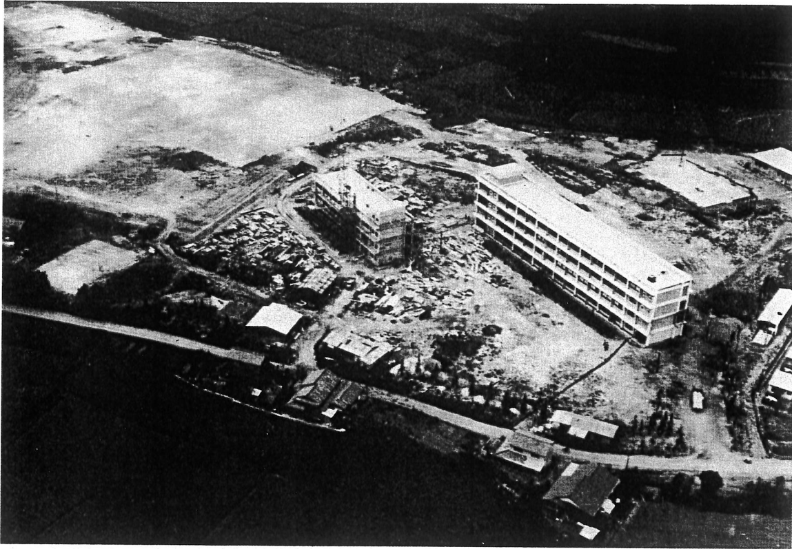
▲建設中の工業高校全景（航空写真・昭和39年）
