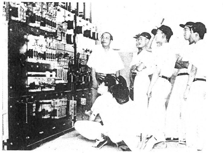
▲電気科実習－電気機器実験（昭和29年度設置）
