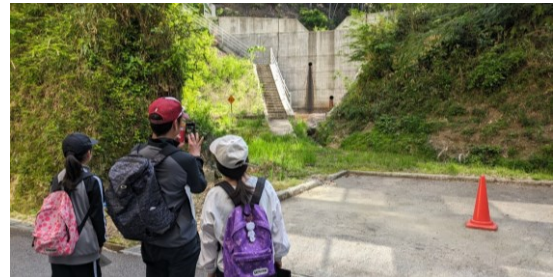
広島女学院大学の奥に建設された治山えん堤
