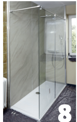
Duschkabine montieren
