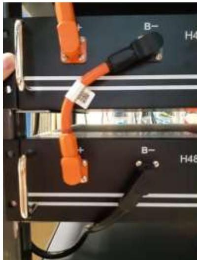
Abbildung 21 - Leistungsverbindung (negativ) zwischen BMS und letztem Batteriemodul
