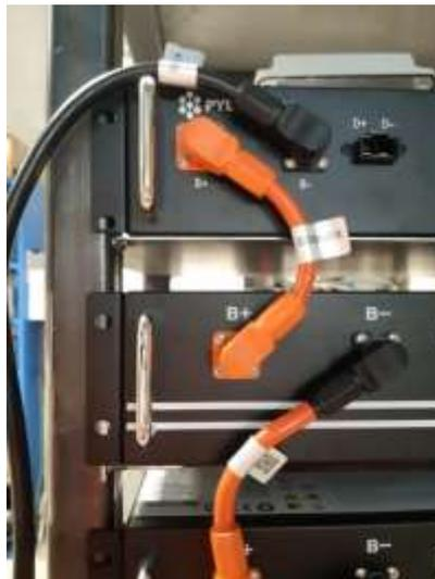
Abbildung 20 - Leistungsverbindung (positiv) zwischen BMS und erstem Batteriemodul
