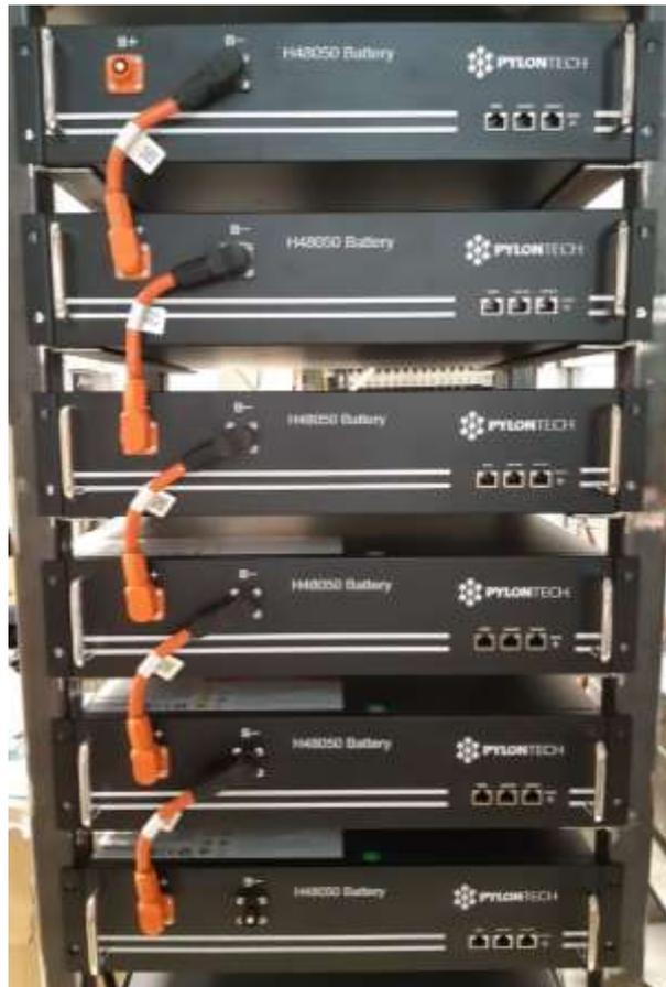
**Figura 18 - Leistungsverkabelung zwischen Batteriemodulen**
