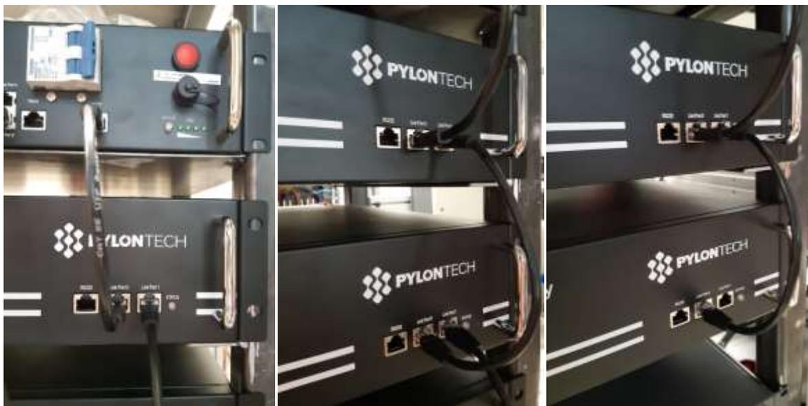
Abbildung 25 - Kommunikationsanschlüsse: BMS und erstes Batteriemodul (links), Verbindung zwischen Batteriemodulen (Mitte), Verbindung zwischen dem vorletzten und dem letzten Batteriemodul der Serie (rechts)
