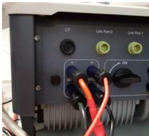
Abbildung 41 - DC-Leistungsverbindung Inverterseite mit einem belegten doppelten Batterieeingang
