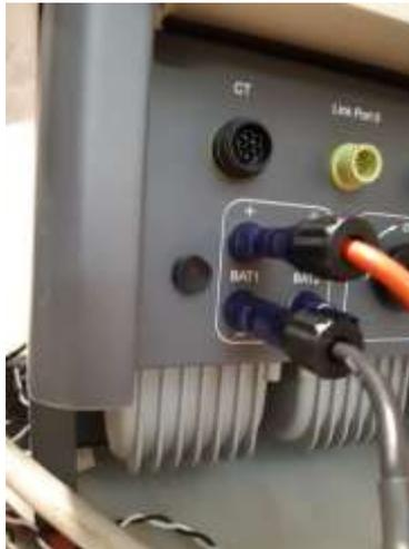
Figura 24 - DC-Leistungsverbindung Inverterseite mit nur einem belegten Batterieingang
