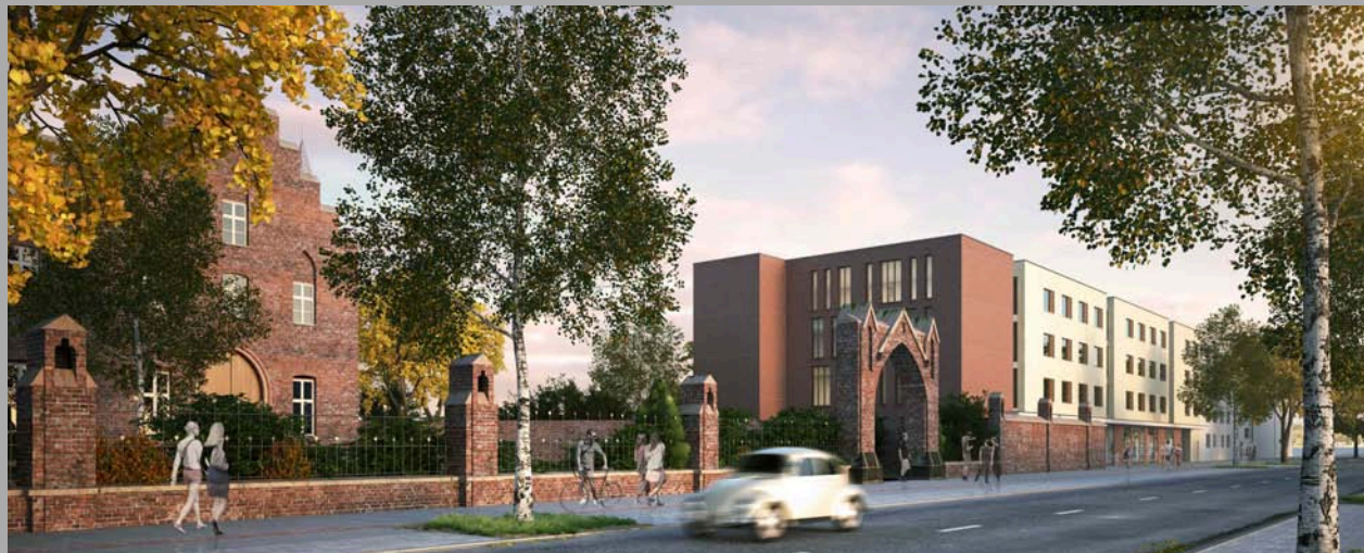
B54, BRÜHLER STRASSE, KÖLN
