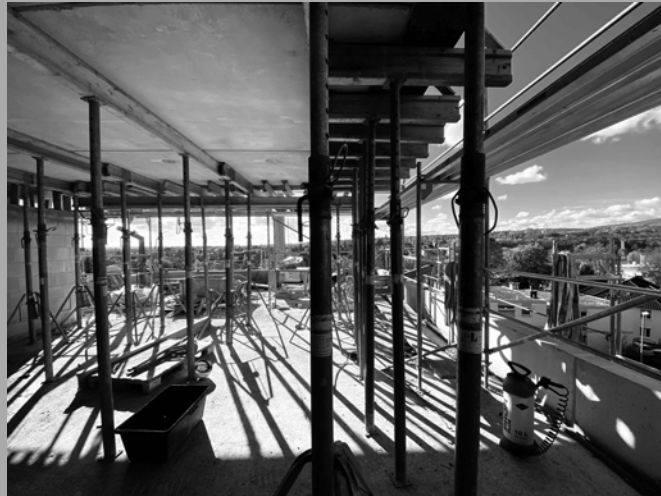
ROHBAU-FOTOS: MATTHIAS DITTMANN
