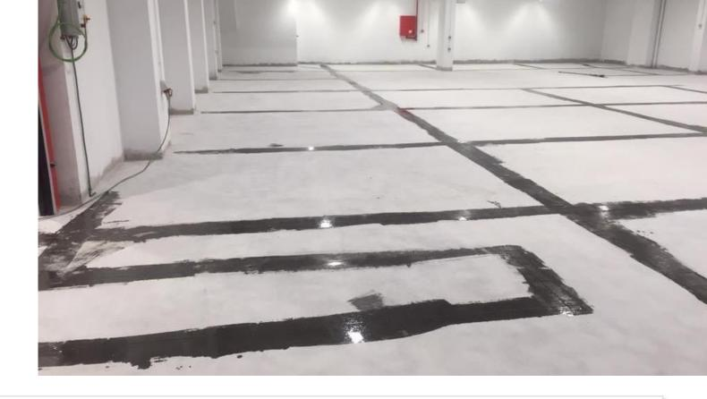
2 Sellado de juntas y reparación de coqueras
