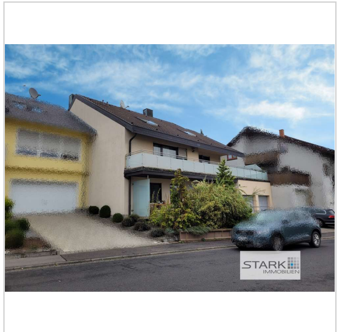
Außenansicht von der Straße
