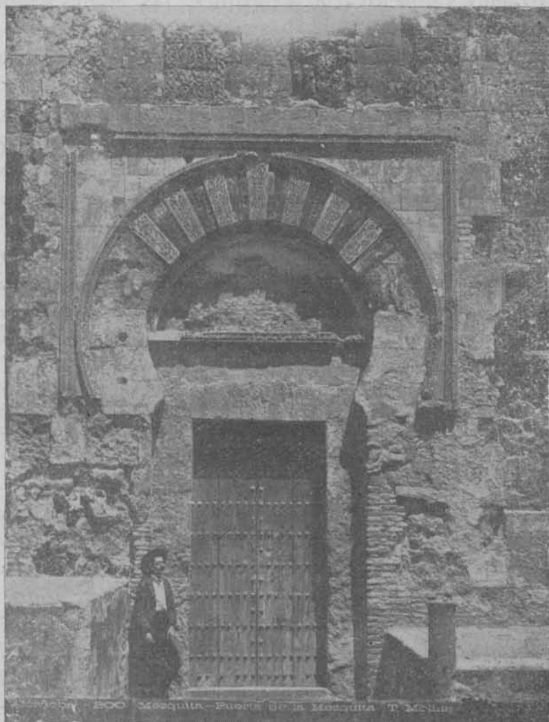
Puerta de San Esteban antes de la restauración de sus jambas
