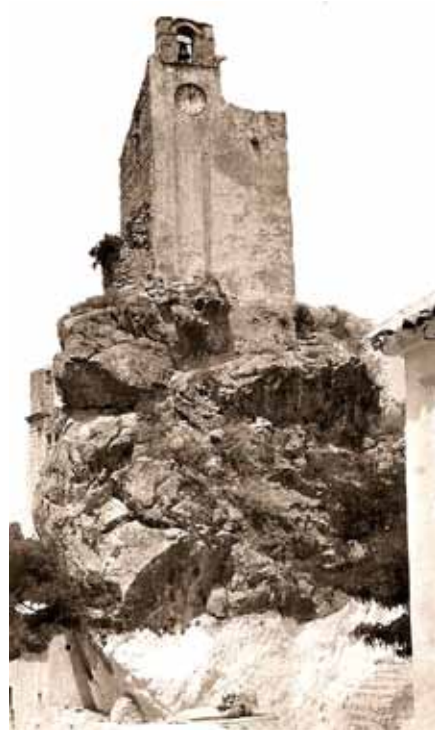
Zuheros en 1927: La Torre del Reloj .El torreón del castillo se ha convertido en Torre del Reloj: Consta de una especie de casamata para colocar la maquinaria del reloj, con su esfera para ver la horas a distancia, se ha construido una espadaña donde se ha colocado la campana primitiva del reloj de 1760, para dar las horas. La torre del castillo para convertirla en Torre del reloj se ha enjabelgando por la fachada que da a la plaza. Todo costeado por el Ayuntamiento que presidía D. Francisco Zafra Poyato según acuerdo de junio de 1924.
