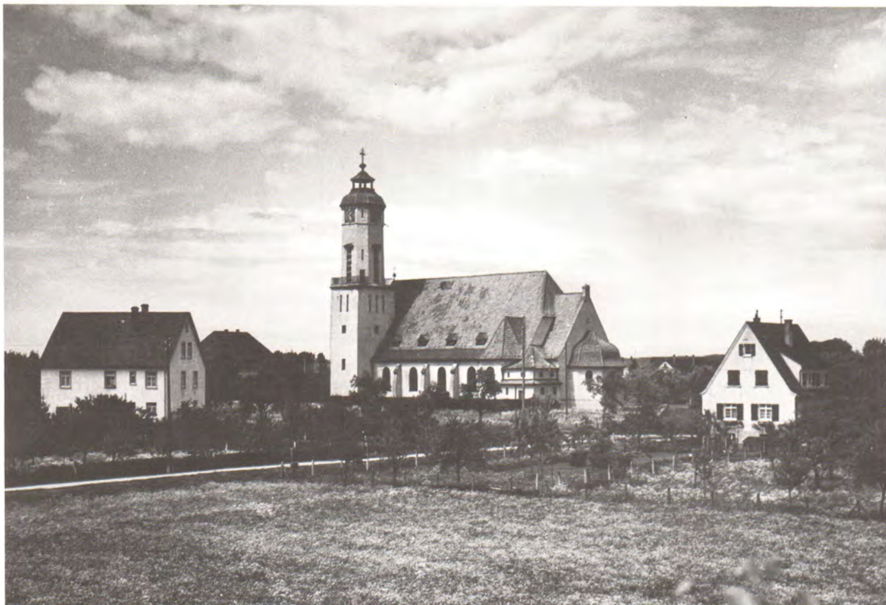
Neue Kirche, erbaut 1914/15, mit Umgebung um 1940
