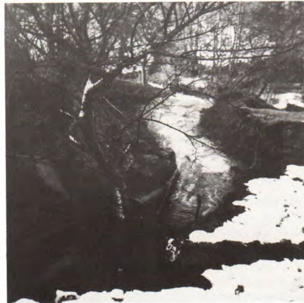
Rohrbruch der Landeswasserleitung beim Felbenhaus in Metlangen am 2. Dezember 1962
