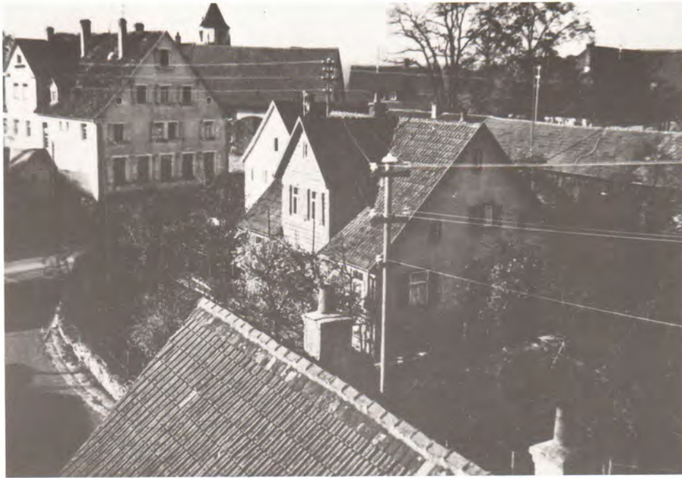
Altes Schul- und Rathaus, Haus Heinrich (vor dem Ab- bruch 1990)
